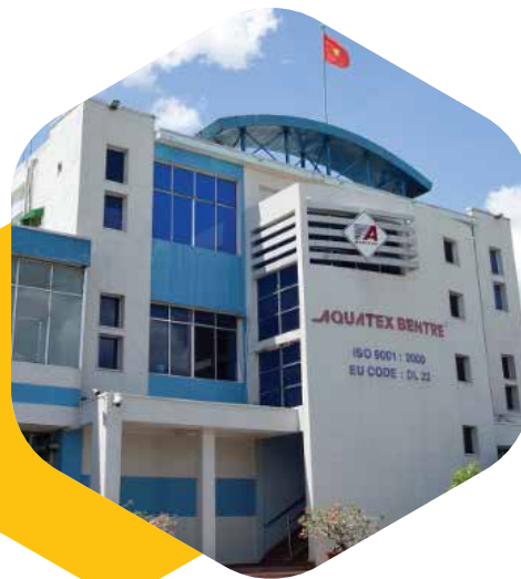
Nhà Máy Chế Biến Thủy Sản Bến Tre
